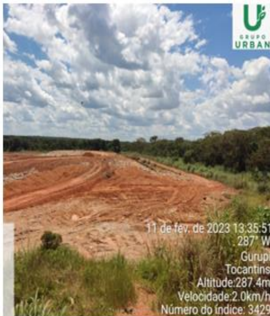
Figura 1 COBERTURA E COMPACTAÇÃO DOS RESÍDUOS SÓLIDOS
