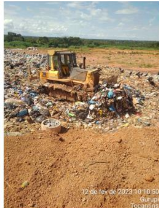
Figura 14 ESPANAMENTO E COMPACTAÇÃO DOS RESÍDUOS SÓLIDOS
