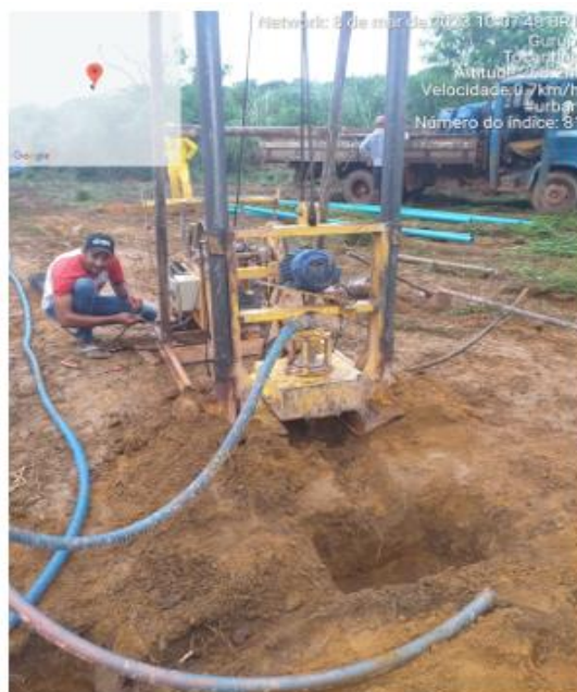
Figura 5 PERFURAÇÃO DE POÇO NO DIA 08-03-2023
